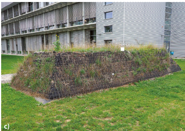
Bild 1: Elemente Urbaner Grüner Infrastruktur a) Dachbegrünung, b) Grüngleise, c) Geokunststoffbewehrter Erdkörper, d) begrünte Gabionen
