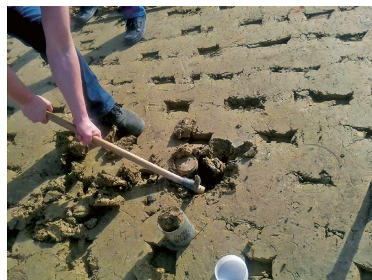
Bild 6: Repräsentative Probenahme der ersten Lage der mineralischen Dichtung eines Basisdichtungssystems
