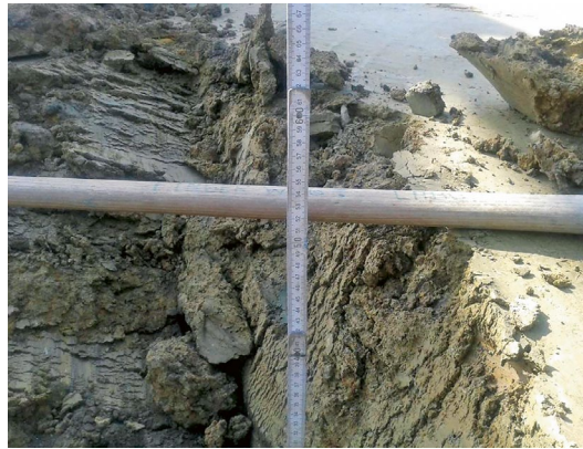
Bild 7: Beprobung und Schichtstärkenüberprüfung der zweiten Lage der mineralischen Dichtung eines Basisdichtungssystems
