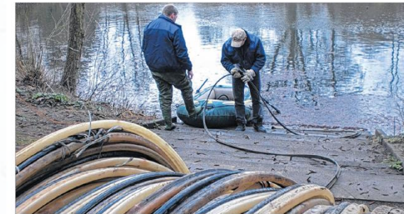
Das Schlauchsystem wird auf dem Grund des Ritterweihers verlegt. (Foto: pv)
